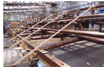
加工場で仮組みが行われる大屋根。組み立てながら歪みがなければ確認し、部材を修復する。
